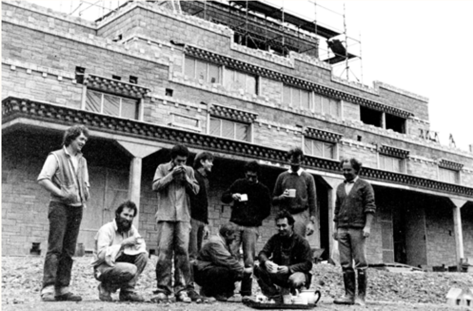
Vin Harris mit einem Tempel-Bauteam
